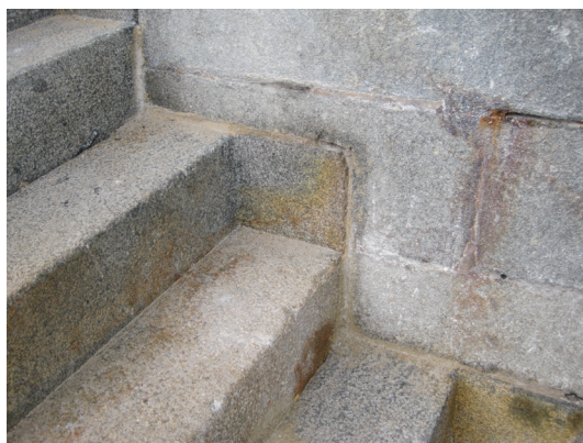
Pour renforcer la solidité de l'escalier, les doubles marches s'encastrent dans les pierres du rempart.
