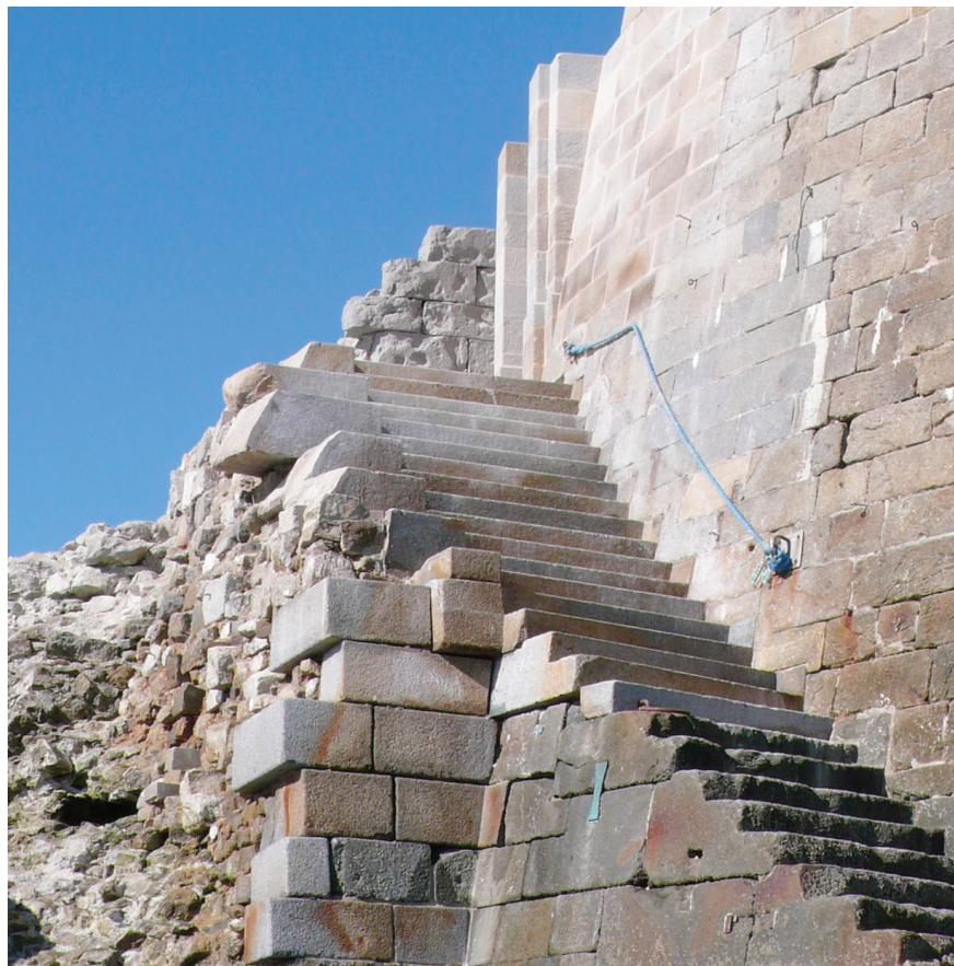
Dix neuf marches relient l'ancien escalier à la plateforme en avant de l'entrée du fort facilitant ainsi son accès
