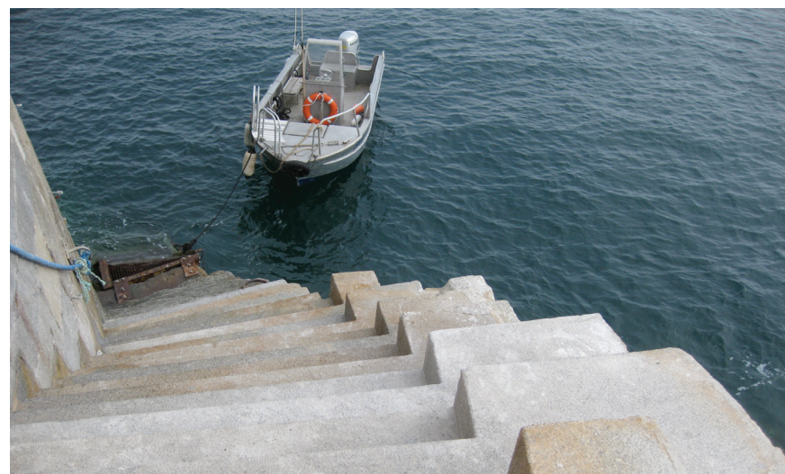
Chaque double marche est constituée d'un seul bloc de granit pesant près de deux tonnes. De longues tiges filetées les scellent dans le rocher.
